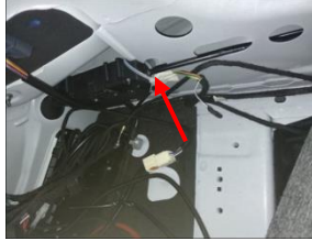
1.8 用扎带把箭头位置的拉线固定好,防止拉线与盖板、钣金摩擦;
